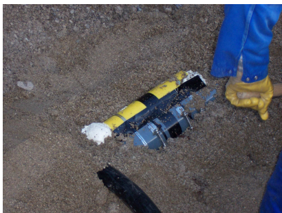
Anbringung des mechanischen Schutzes
