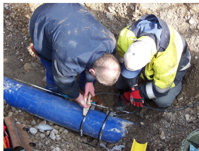
Installation der Sensoren
