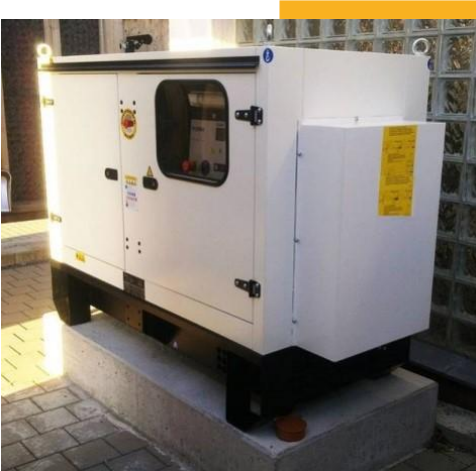
Netzersatzaggregat
