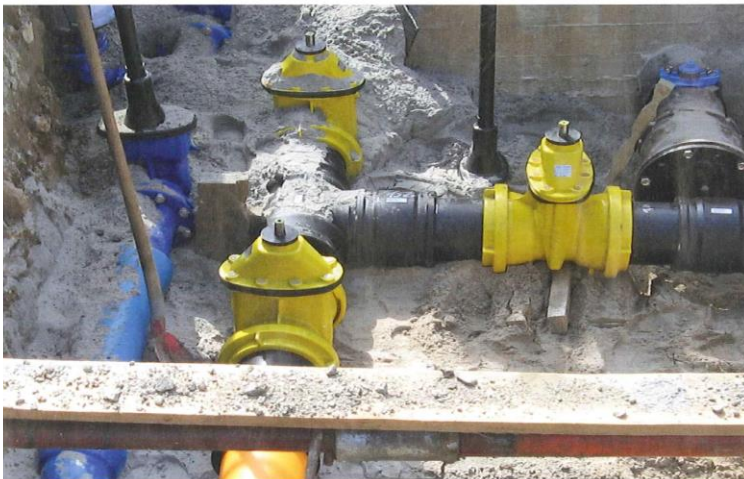
Einbau eines Schieberkreuzes zur Verzweigung der neu verlegten Versorgungsleitungen
