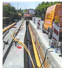
Dichtheitsprüfung der neu verlegten Gas- und Wasserversorgungsleitungen durch die beauftragte Verlegefirma
