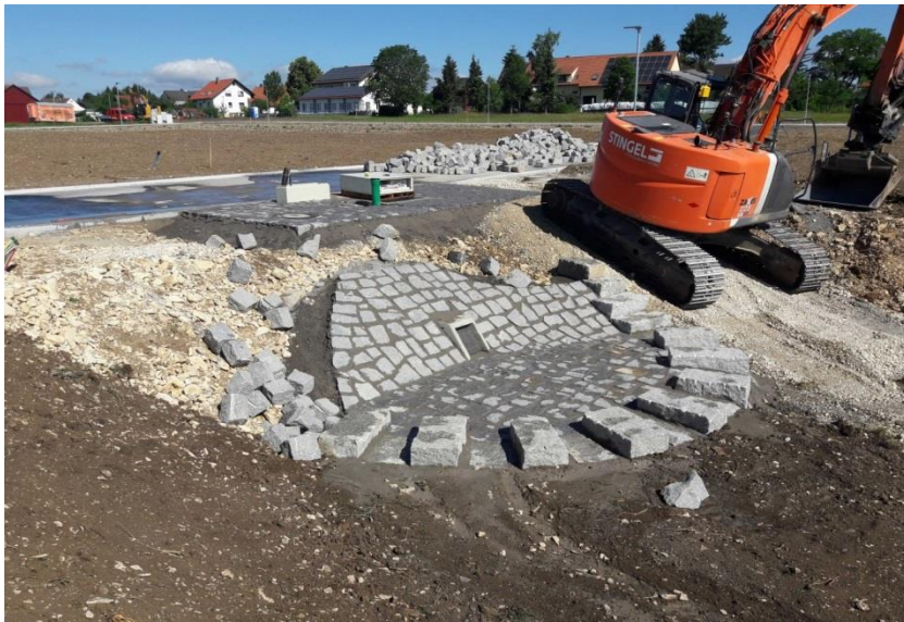
Herstellung der Versickerungsbecken mit Blick ins Baugebiet
