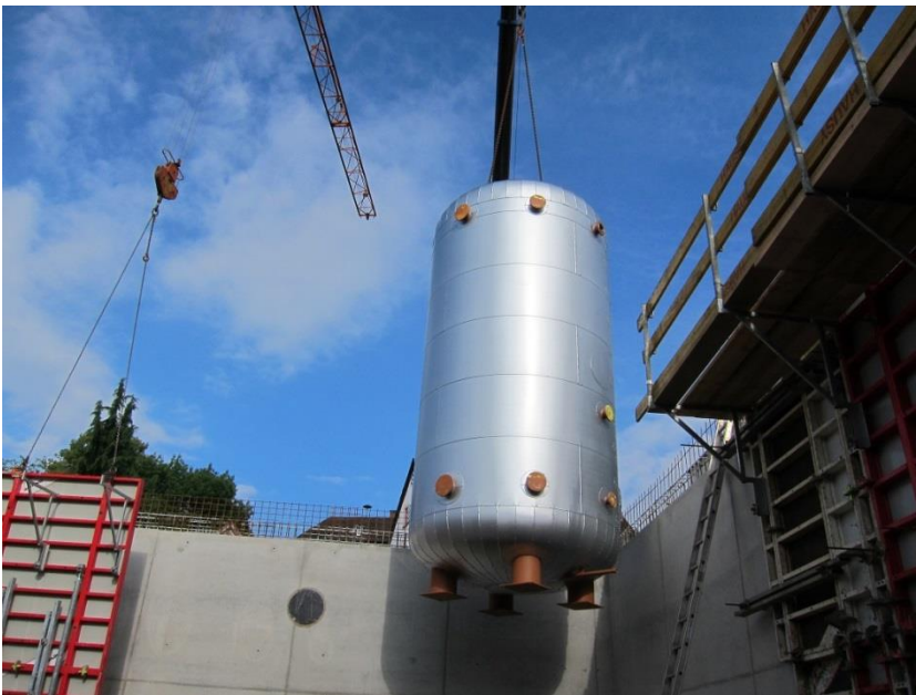
Einbringung des Pufferspeichers in der neuen Heizzentrale der Stadtwerke Wehr 07/2016
