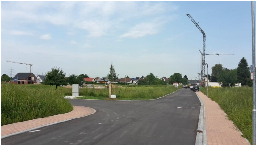
Blick ins Baugebiet
