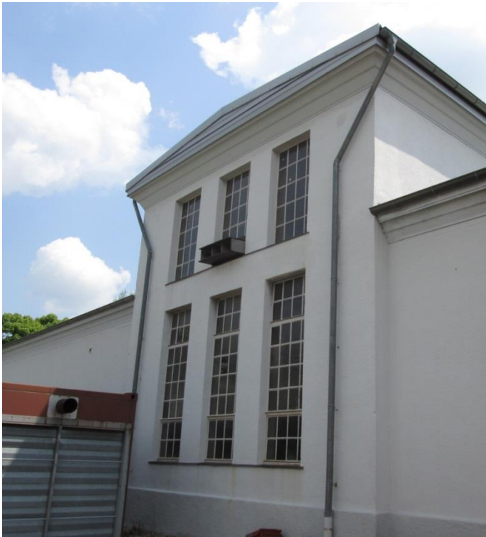
Bestehendes Umspannwerksgebäude für die Aufnahme der Heizzentrale
