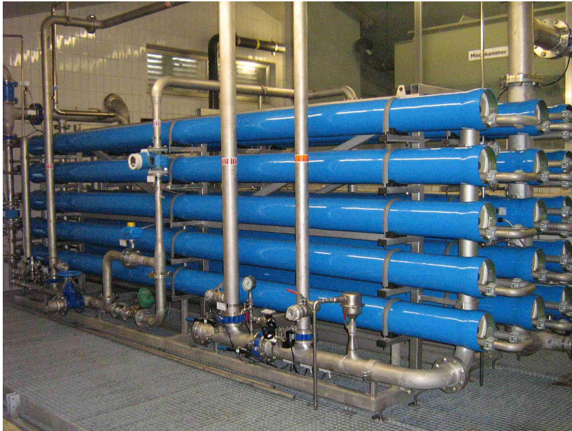
Enthärtungsanlage
