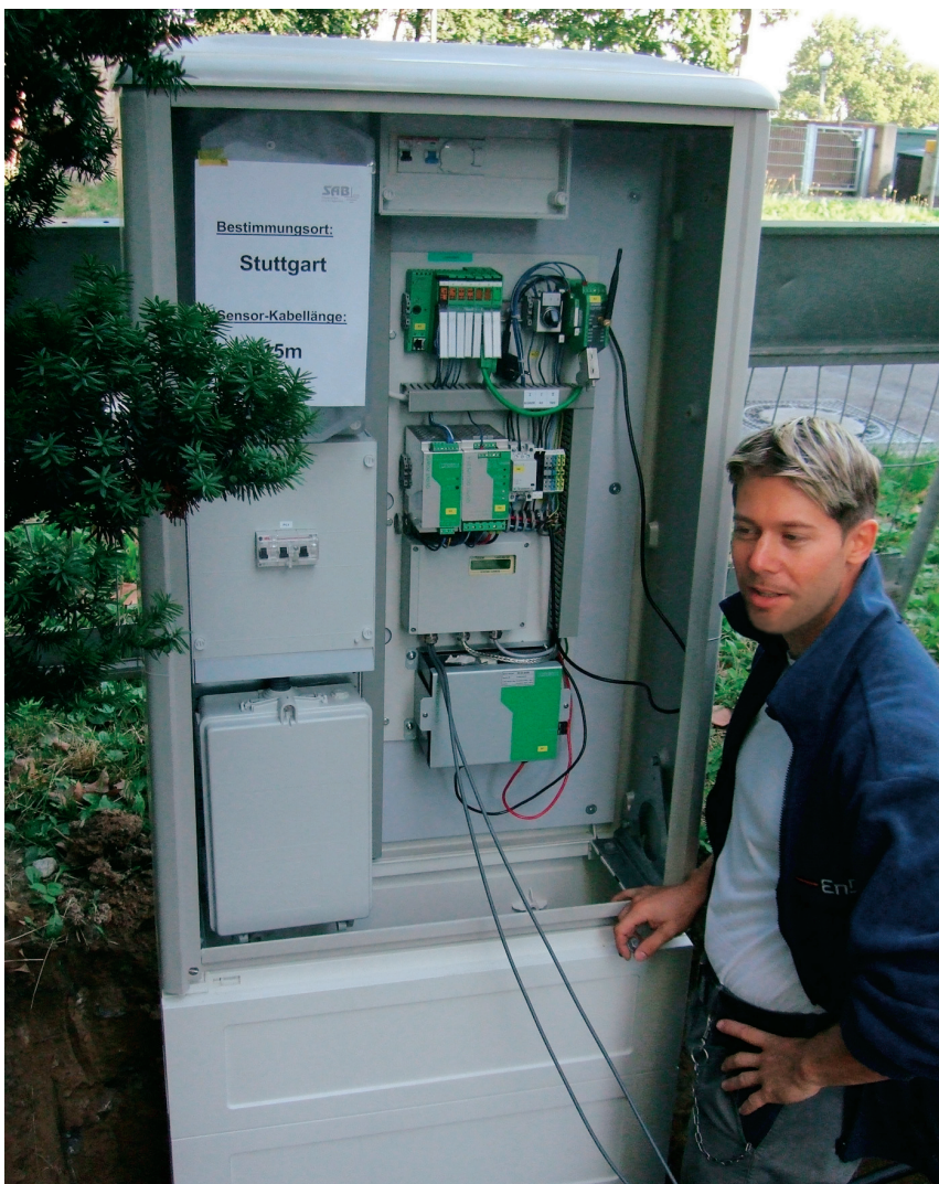
Abb. 4: Schaltschrank mit dem Messumformer für die Ultraschalldurchflussmessung und der Kommunikationstechnik für die kabellose Übertragung der Messwerte an eine zentrale Leitwarte
