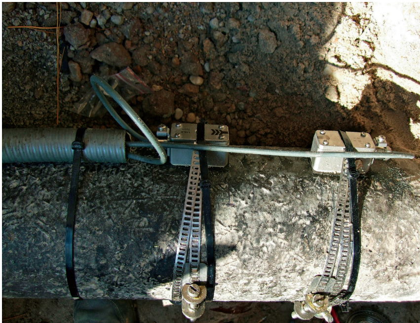
Abb. 3: Erdverlegter Einbau ohne Schachtbauwerk
