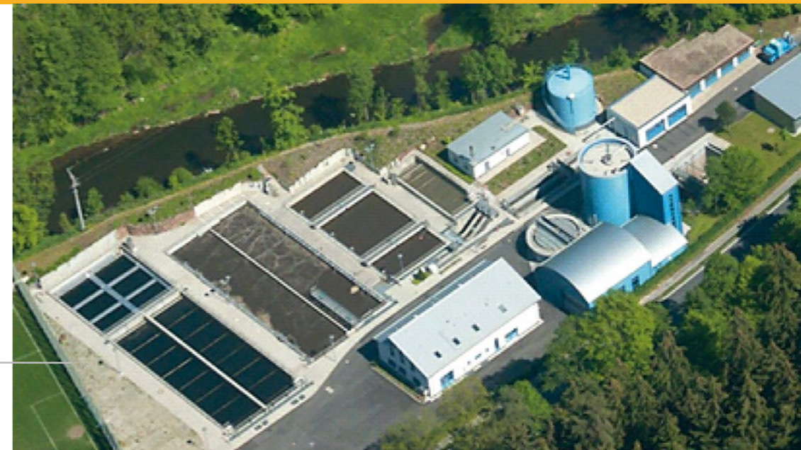
Kläranlage (Bad Liebenzell) mit einer Ausbaugröße von 25.000 EW
